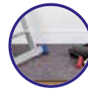
Proteção do piso durante a obra e reforma.
