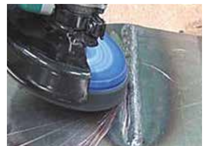
*Removendo queimaduras em soldas.
